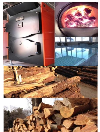
木質バイオマスボイラー 敷地内の枝木や薪で燃焼
